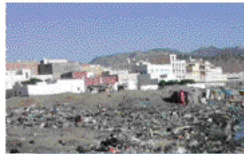
Quelques aspects de la destruction d’habitats dans les régions d’El Jadida (Bas) et Nador (Haut)
